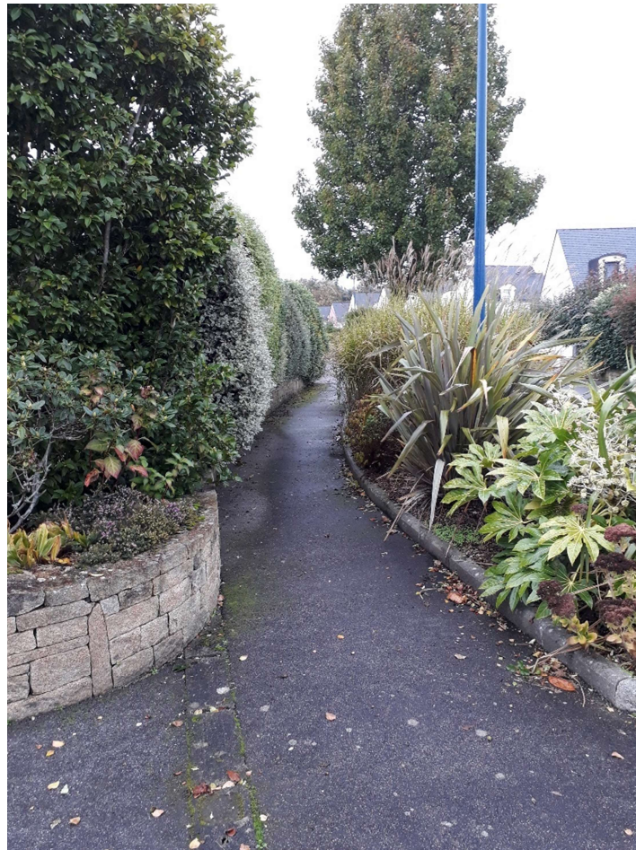
Certains cheminements sont réduits en largeur par la végétation bordant la voie piétonne
