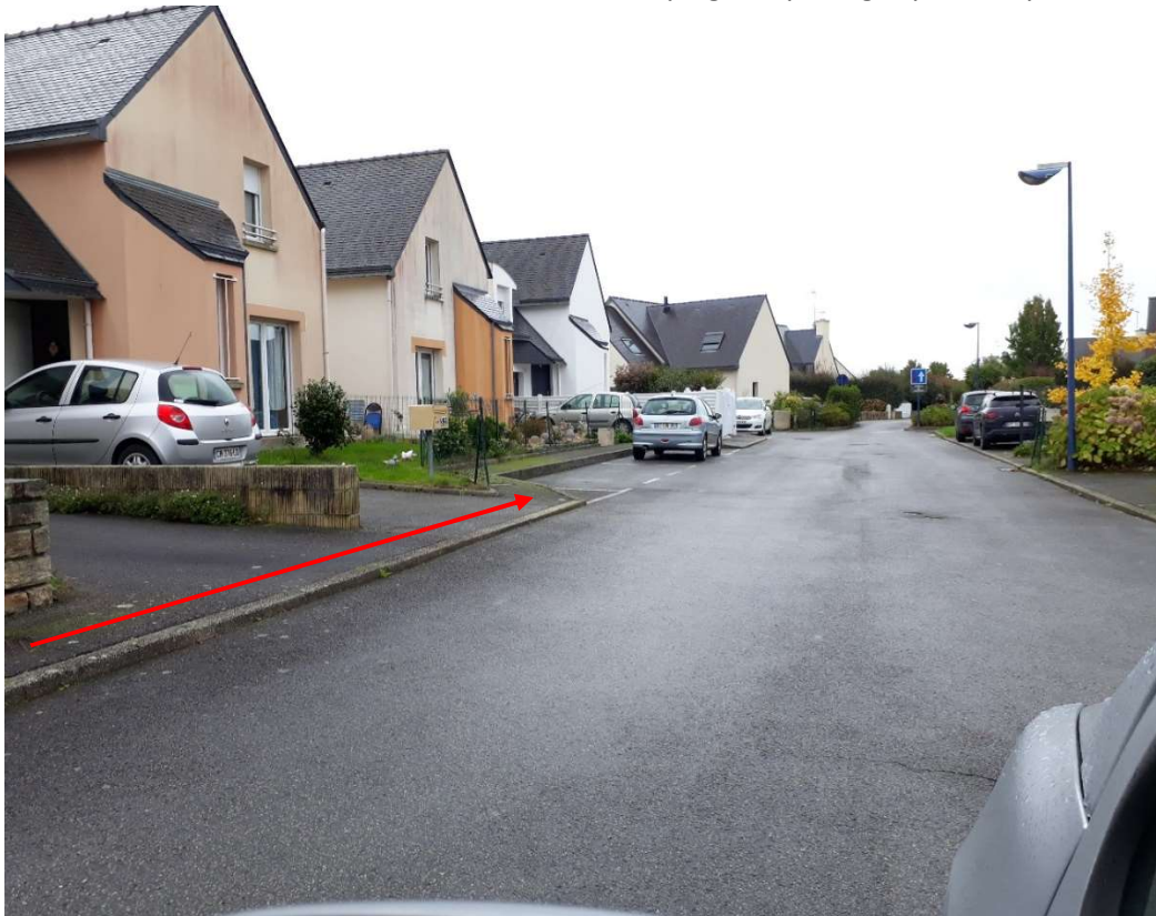
Largeur du trottoir trop faible, cheminement inadapté pour les PMR
