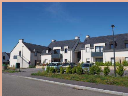
Opération immobilière récente © Territoire +
